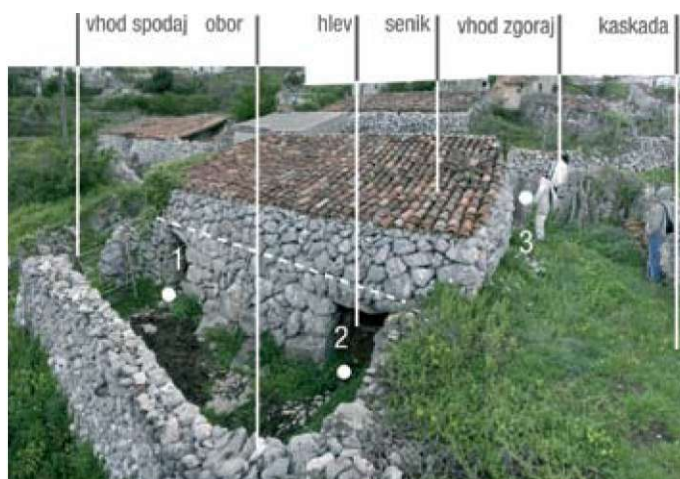
Slika 5: Obor z objektom in shema funkcionalne izrabe. Spodaj je hlev, zgoraj je senik v kombinaciji z orodiščem. Hlev je dvočeličen, ima dva vstopa (oznaka 1 in 2); delitev prostora v hlevu je izvedena s prepletom šibja. Zgornja etaža je enocelična z vstopom označenim s številko 3. Na fotografiji se dobro opazi enovitost naklonov strešin objektov, ki so skoraj vzporedne s padajočim terenom.
