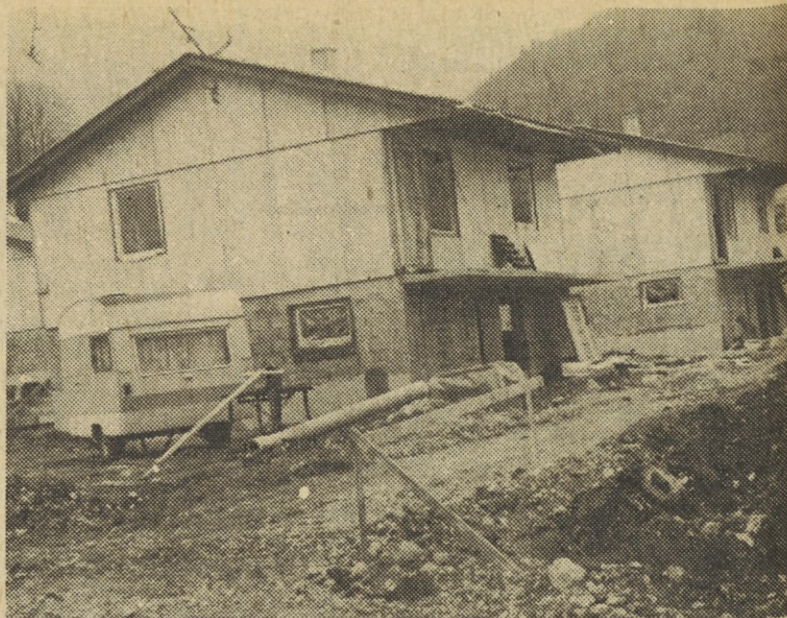
Nova podoba Voljč, v priklopi ob prvi hiši so domovali naši monterji, ki so delali na tem gradbišču
