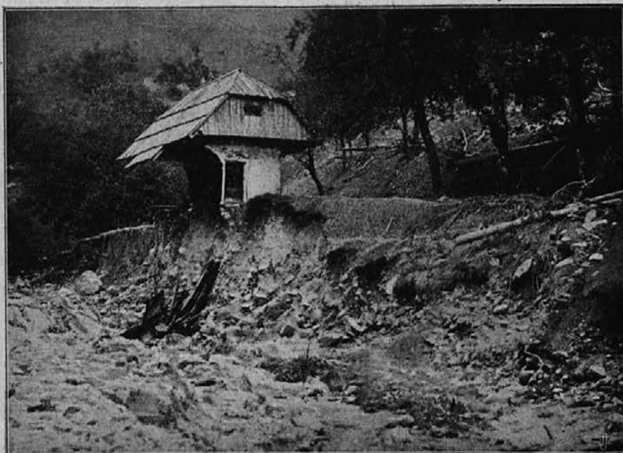
Polhov Gradec: Po povodnji porušena sušilnica za sadje.
