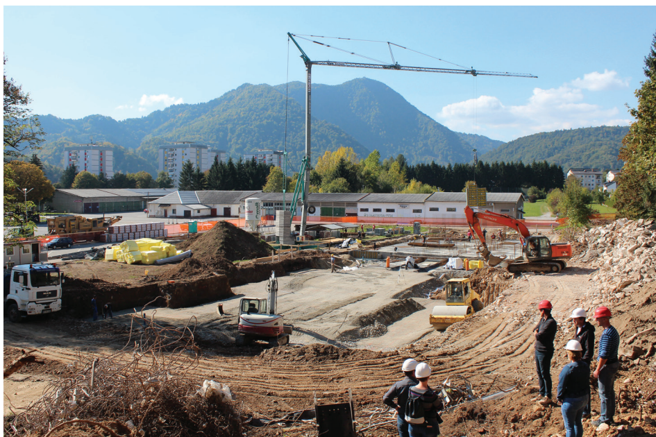
Gradnja se je začela. (foto: Matic Lasič)
