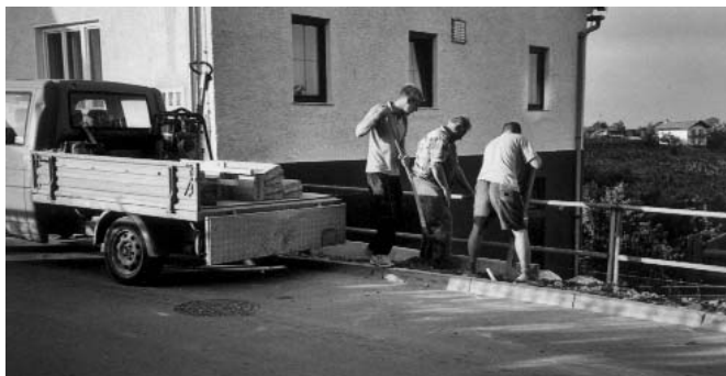
Asfaltiranje pločnika - na prireditve ob občinskem prazniku bomo hodili že po njem.
