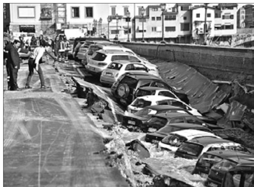
Pogled na parkirane avtomobile, ki jih je »požrlo« brezno ob reki Arno ANSA
