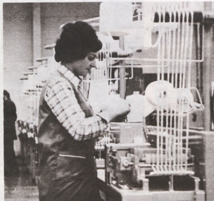
Pređenje ST preje na Repco predilniku
