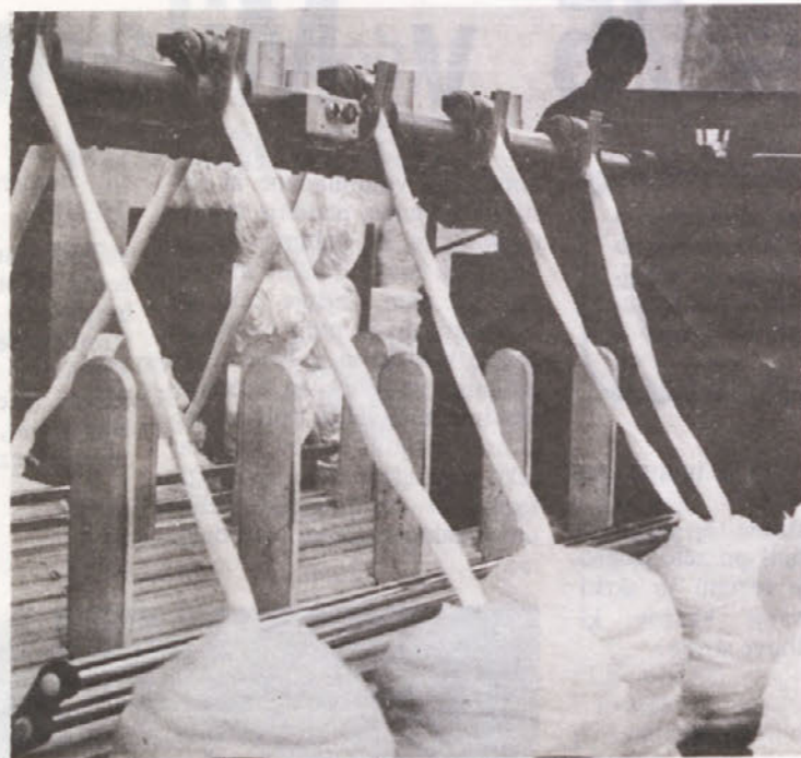
Rastezanje volne v novi predilnici
