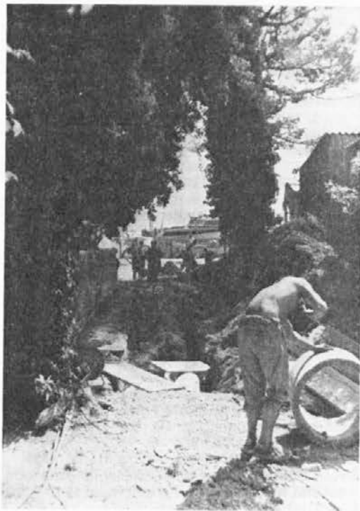
Polaganje kanalizacije v Portorožu
