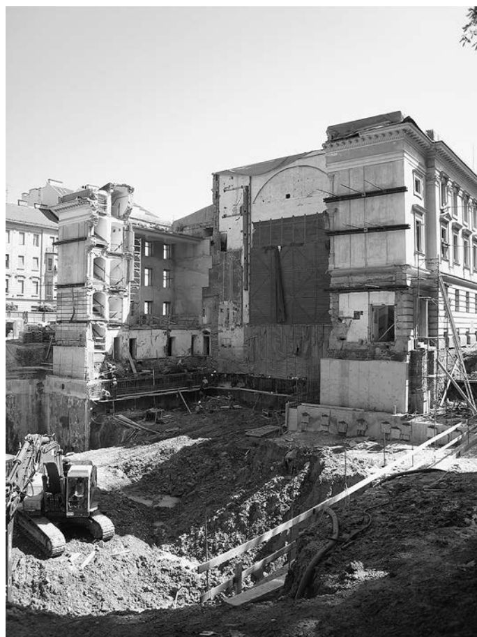
Gradbena dela prenove gledališke stavbe 2007 – 2011
