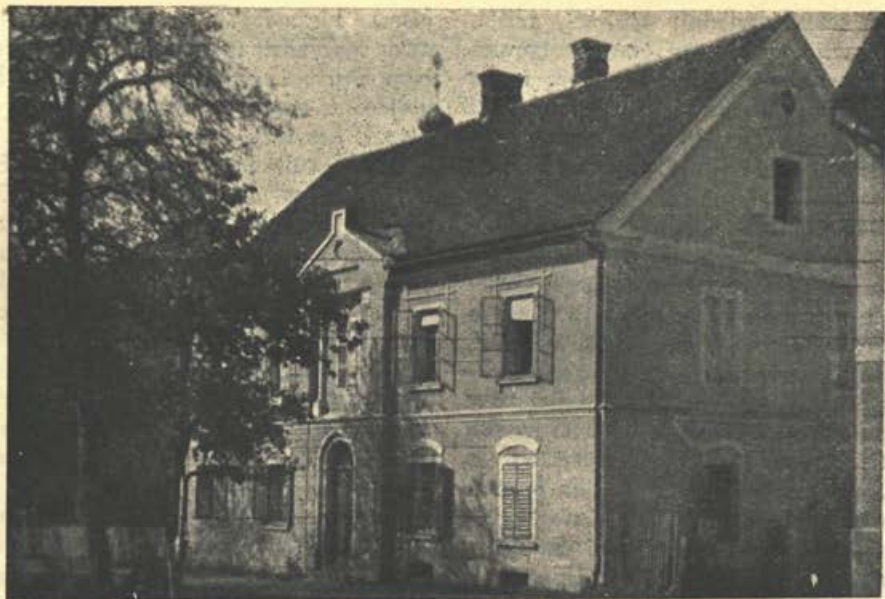
Upravno poslopje Mohorjeve družbe na Prevaljah (Pri fari).
