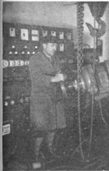
Stari strokovnjak, ki je pred kratkim odšel v zaslužni pokoj, namešča na novo previt elektromotor za preizkus. V ozadju stikalna plošča elektrostrojnega obrata
