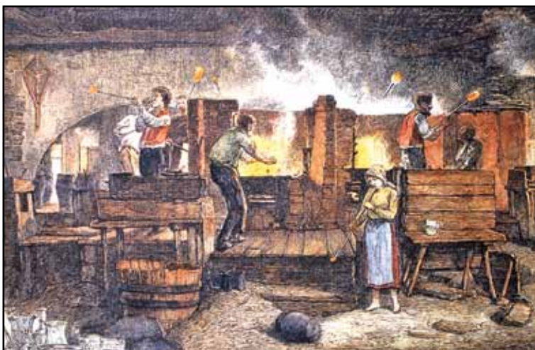
Slika 6: Notranjost limbuške glažute pri Arehu leta 1887 (H. Charlemont - naknadno obarvana). Steklovina se dvanajst ur topi pri temperaturi od 1.200 do 1.300 °C, nadaljnjih 8 do 10 ur pihalci izdelujejo posode pri delovni temperaturi okoli 800 °C.
