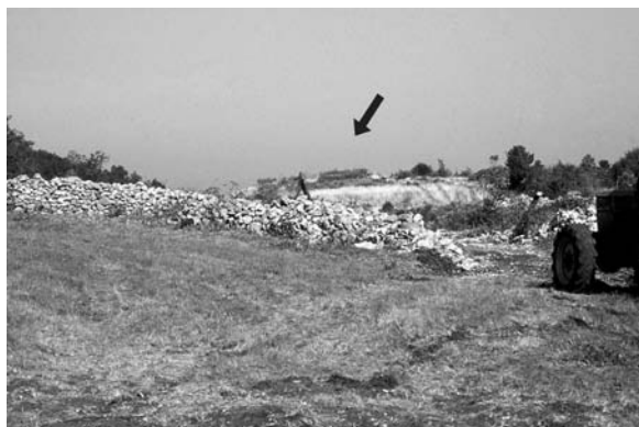
Sl. 2: Žirje, Volarije. Pogled na plato Volarije pred gradnjo avtoceste. Fig. 2: Žirje, Volarije. View of the Volarije plateau before construction of the highway.
