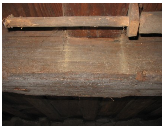
Prečni tram lesenega stropa v sobi
