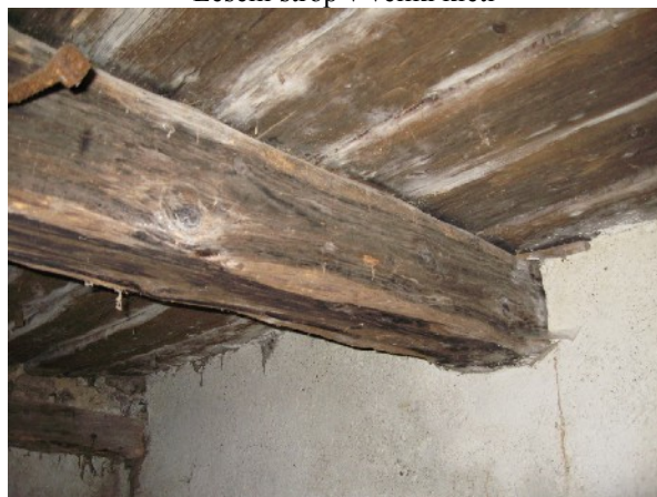
Leseni strop v veliki kleti
