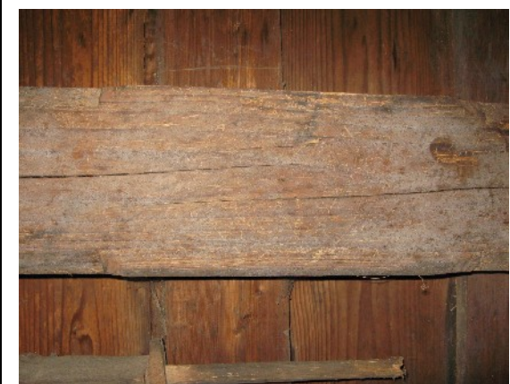
Prečni tram lesenega stropa v sobi
