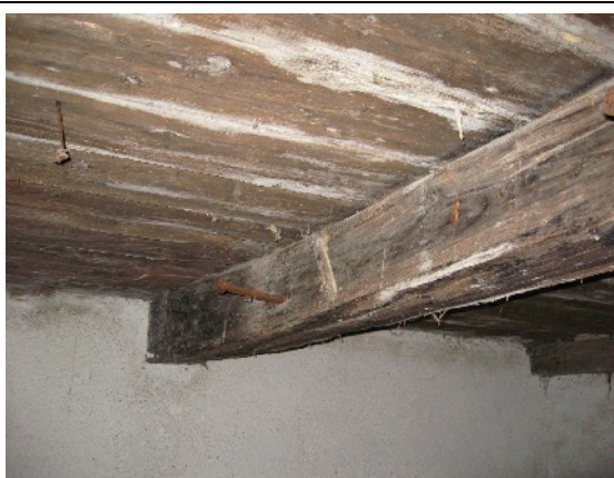
Leseni strop v veliki kleti
