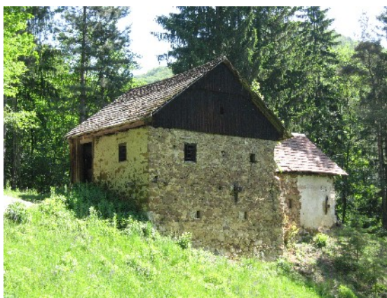
Zidanica z zahodne smeri
