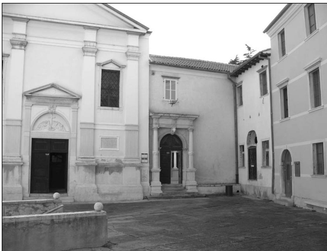
Sl. 1: Pogled na pročelje nekdanje cerkve sv. Katarine med vhodom v križni hodnik minoritskega samostana in stavbo nekdanje šole, danes Inštituta za dediščino Sredozemlja ZRS Univerze na Primorskem (foto: A. Preložnik).
