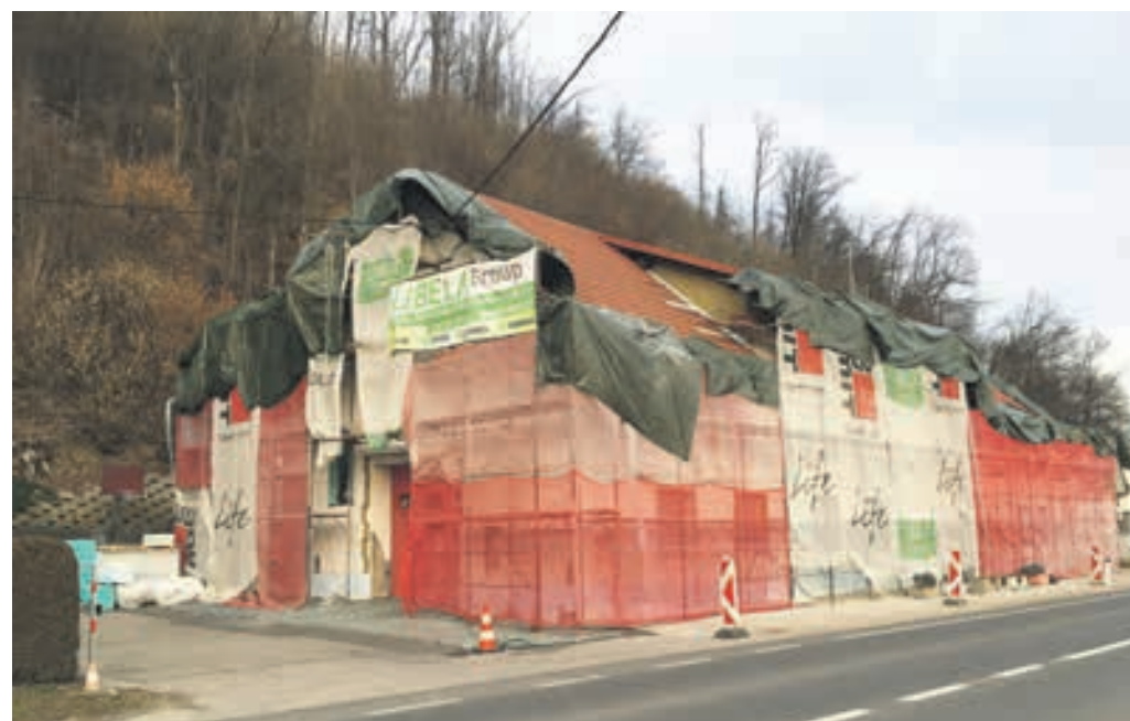
Med prenovno fasade
