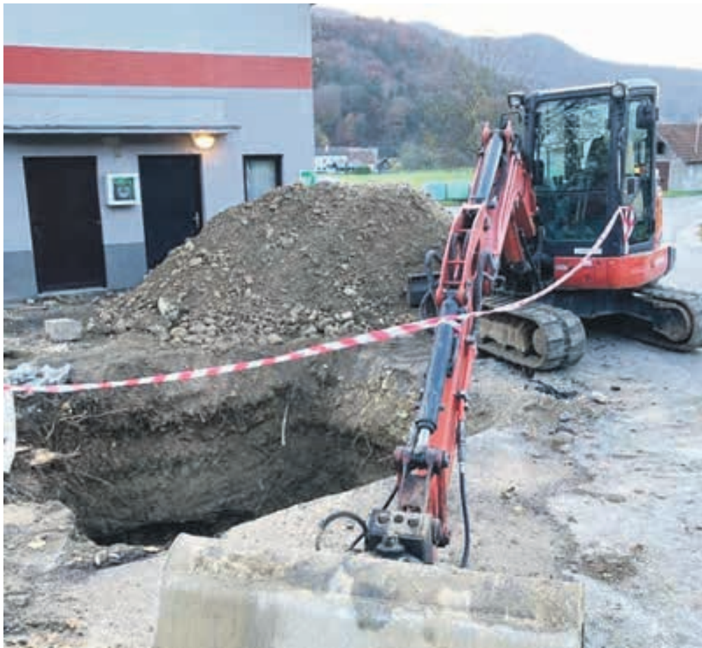
Gradbena dela pri gasilskem domu
