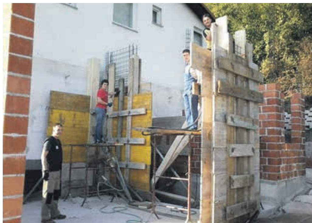
Začetek gradnje prizidka
