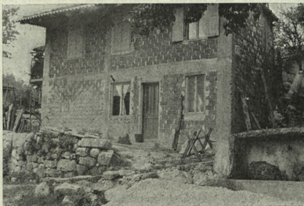
Sl. 6. Z vertikalnimi vezmi ojačana hiša v Breginju po potresu 15. septembra 1976
