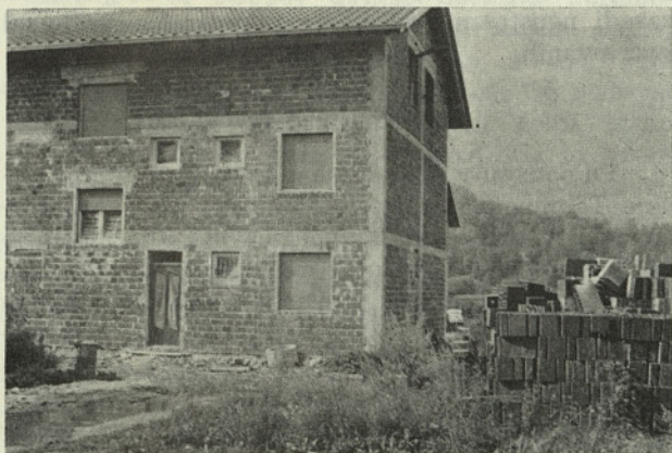
Sl. 5. Pravilno izdelane vertikalne vezli v Kobaridu
