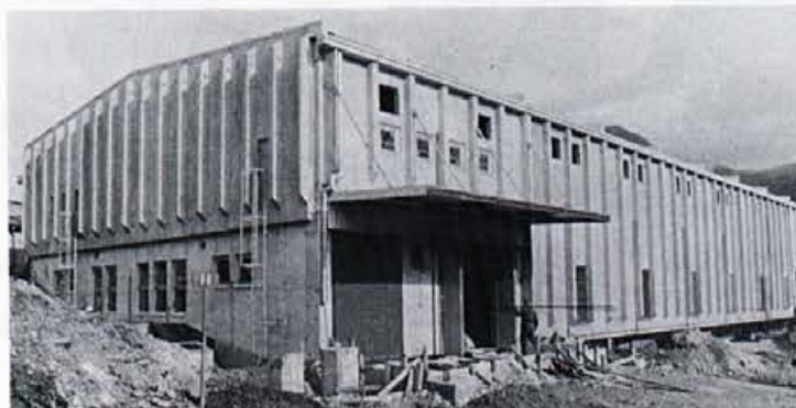
Finis skladišča vnetljivih materialov
