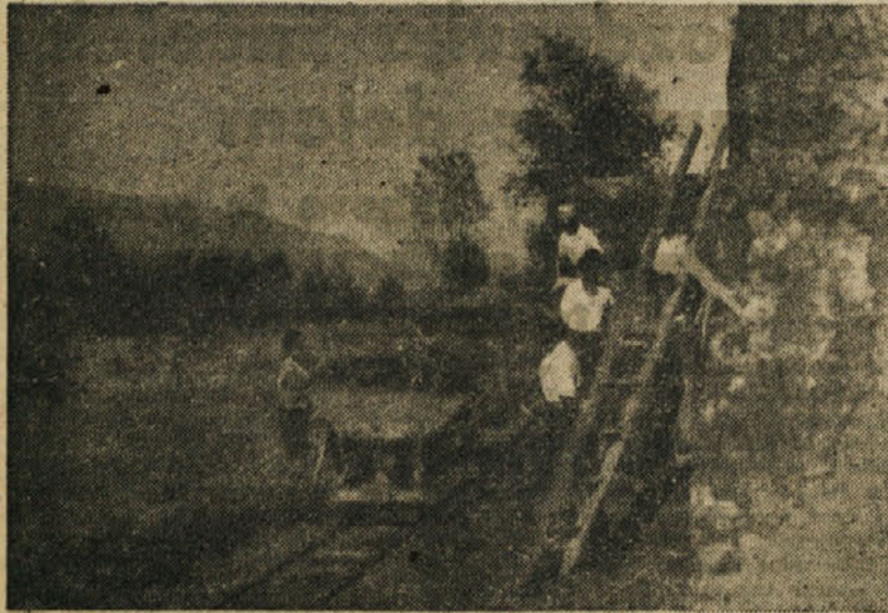
Na glinokopu prav pridno kopljejo glino in jo nalagajo na vagončke
