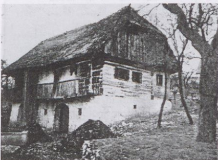
Revnejša vrhhlevna hiša na pobočju, ki ima zaradi nagnjenega terena vhod v stanovanjski del na zgornji strani
