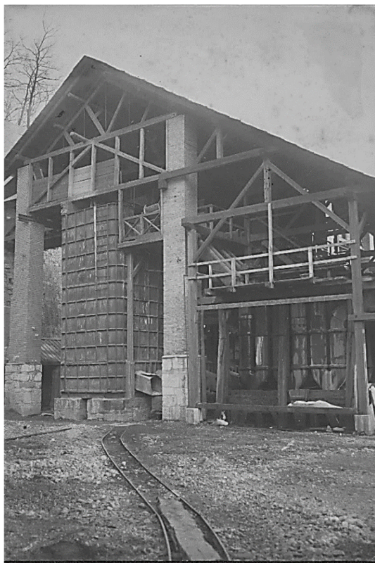
Sl. 4: Jaškasta peč z izsipniki za prežgano rudo in kondenzatorji.
