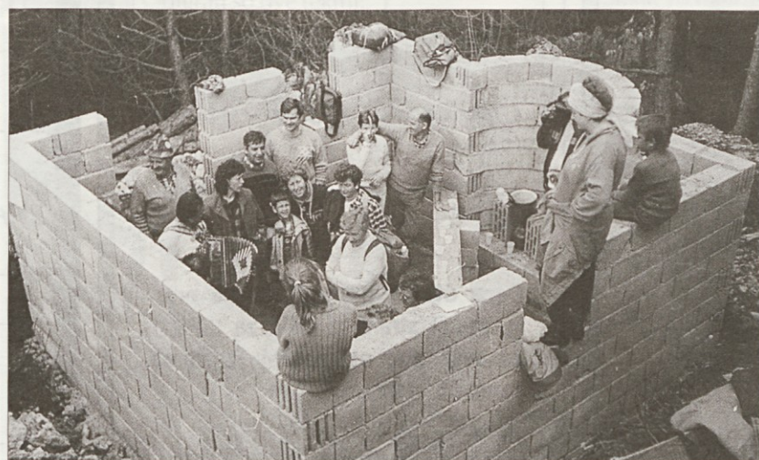
Kozlek, 1. maj 1991. Prvi gradbeni uspeh: postavljeni so že zidovi kleti bodoče koče. Udeleženci srečanja na Kozleku so se ob zvokih harmonike zavrteli in zapeli. (Foto: Vojko Čeligoj)
