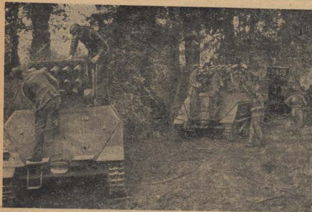
Werferbatterie geht in Stellung
