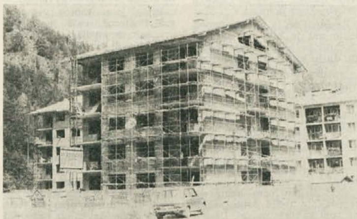
Stanovanjski blok v Črni na Koroškem. TOZD Gozdarstvo Črna je v tem bloku kupila štiri stanovanja in TOZD Žaga Mušenik štiri stanovanja.
