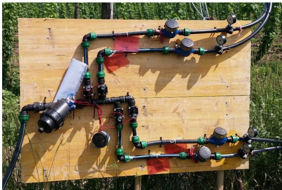
Slika 1: Razdelilna konzola za namakanje hmelja
