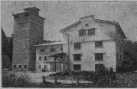
15-tonski obnovljeni mlin z adaptiranim skladiščem in novim 600-tonskim silosom
