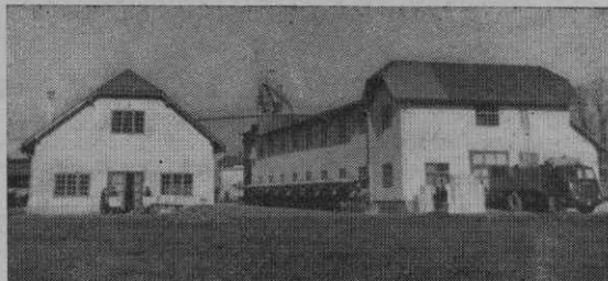
Del tovarniških objektov z odpremnim skladiščem
