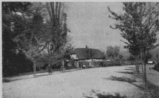
Sl. 3. Hiša na Gosposvetski cesti št. 31 v Mariboru, ki je bila porušena septembra 1953 zaradi predvidenega podaljška Gosposvetske ceste od odcepa Vrbanke proti zahodu. Hiša je bila zadnja lesna — ometana stavba iz dobe starega Maribora, ki je imela v stropniku vrezano letnico 1695. Čez leto dni bo na tem mestu vidna v osi ceste 7-nadstropna stanovanjska hiša in urejena nova cesta
