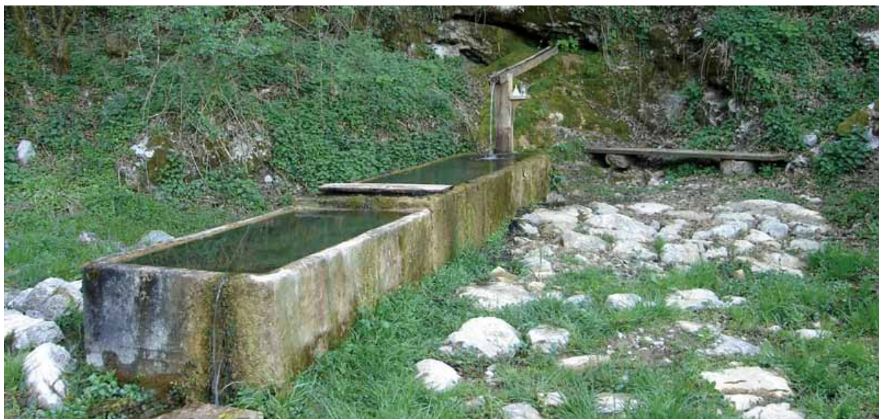
Slika 3: Izvir Močila z betonskima koritoma (foto: Alja Rabzelj).
