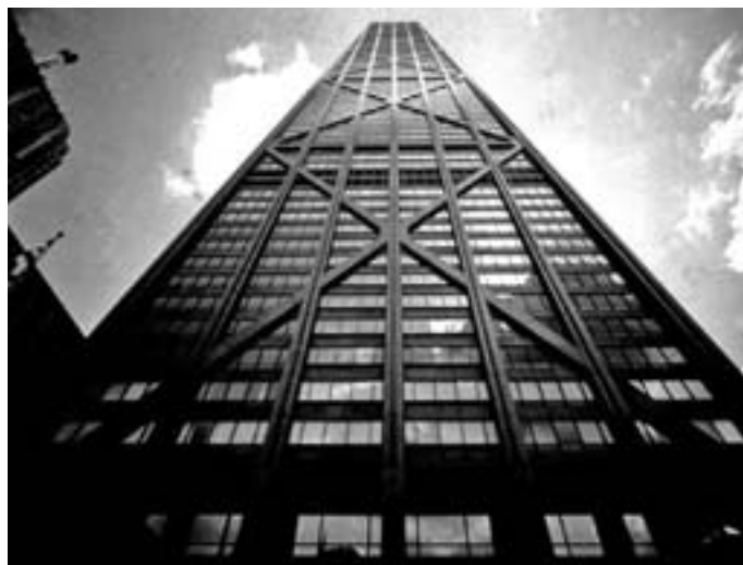
Slika 6: Primer dejanske in vidno izražene konstrukcijske odpornosti na horizontalne (potresne) obremenitve: stavba Hancock v Chicagu s tektonsko obliko (trapezoid) in z vidnimi diagonalami preko fasade. [vir: www.greatbuildings.com/buildings/John_Hancock_Center.html ].
