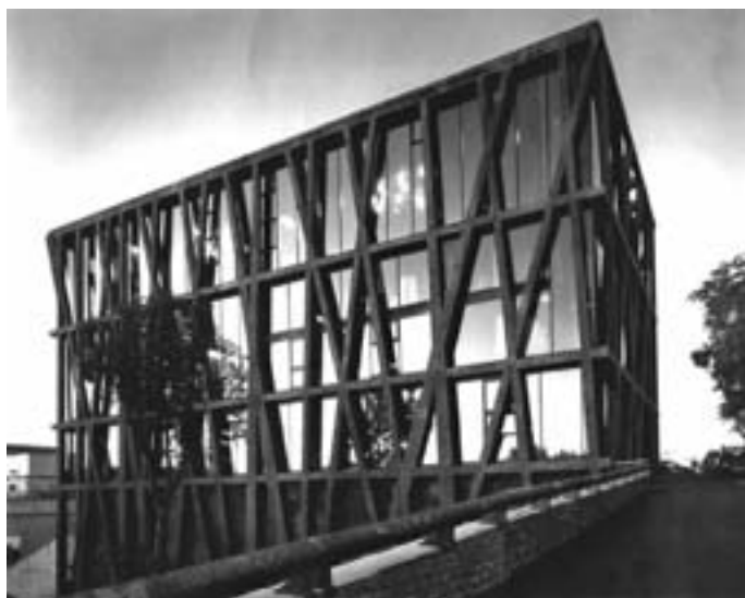
Slika 9: Dva primera identifikacije arhitekture s konstrukcijo: Zgoraj: Palazzo dello Sport [vir: Huxtable, 1960]. Spodaj: Plesni center Aix-en-Provence. [vir: A10, št. 13/2007].
