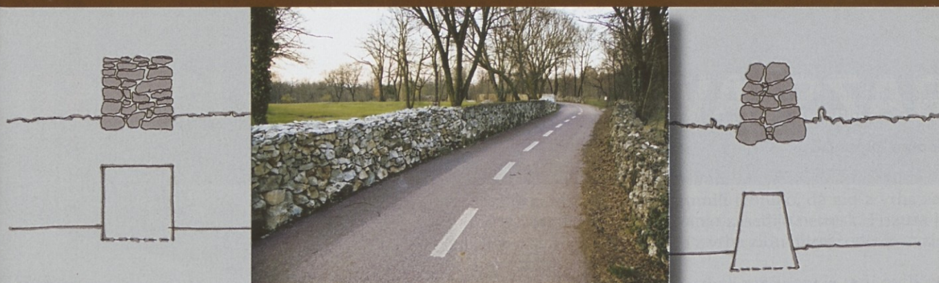
Primerjava starega zidu (desna stran) in novega zidu (leva stran). Fotografija je nastala med Trebčami in Orlekom. Fotografije in risbe: Domen Zupančič.
