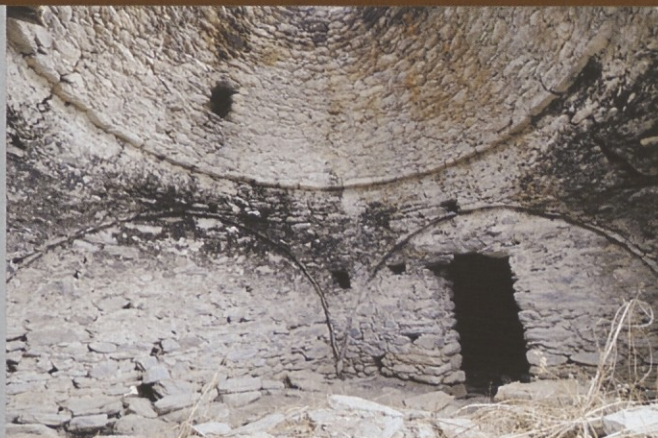
Suvala, Volos Grčija (kakšnih 300 kilometrov severno od Aten in 200 kilometrov južno od Soluna, ob obali): tholos, izjemna konstrukcija, ima tloris kvadraten, vse štiri stene pa so polkrožno vertikalne. Vmesni prostor zapolnjuje korbelling do kroga na višini dveh metrov, čez pa se pne značilni korbelling do temena. Konstrukcije so vedno dvojne, po dve in dve s skupno streho.
