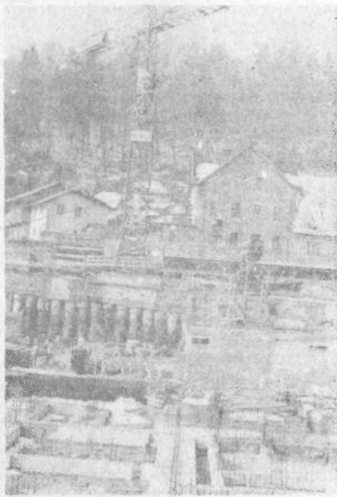
... posnetek graditve v letošnjem marcu.
