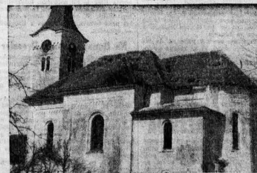
Hotederščica: Poškodovana cerkev pri napadu 18. marca letos
