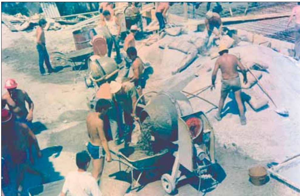
Gradnja gasilskega doma, poletje 1985
