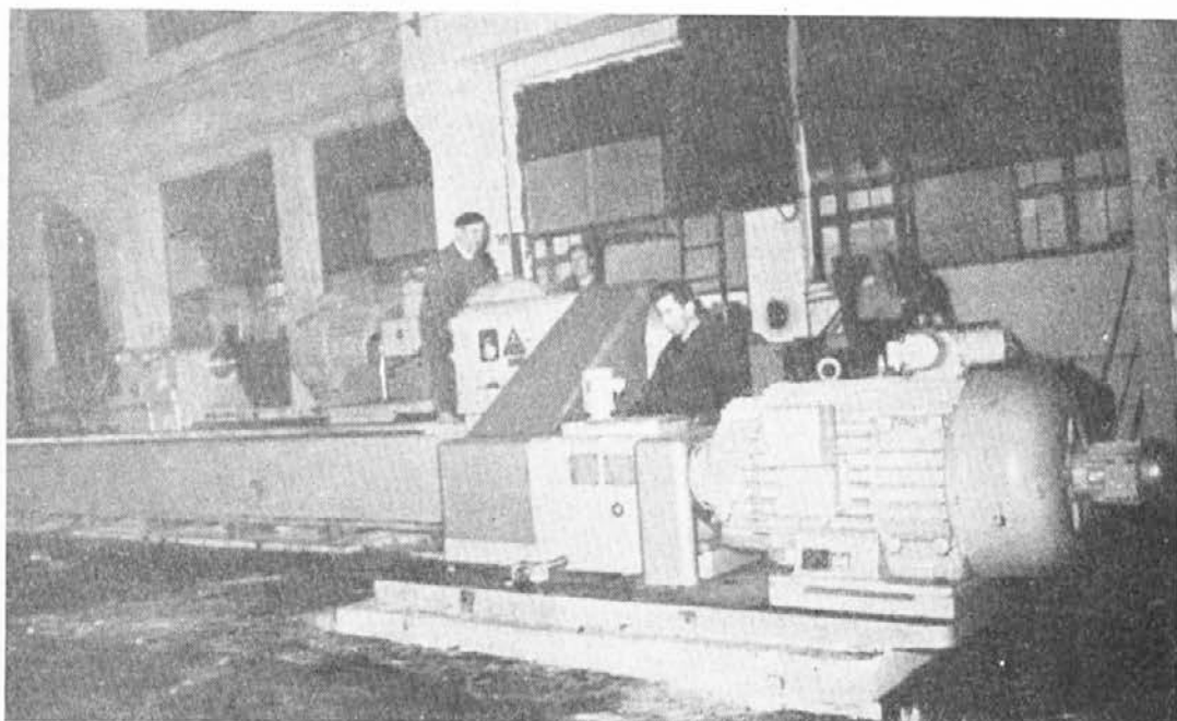
Tam, kjer je bila prej vzmetarna, že postavljamo velik brusilni stroj za brušenje valjev češke proizvodnje BEV 1000 × 5000 mm
