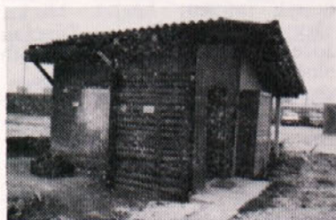
Čaka na rušitev. Tu bo novo poslopje Ingrada.
