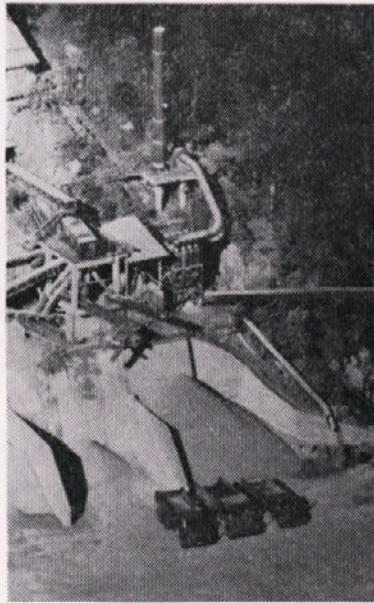
Del separacije z odpraševalno napravo v kamnolomu Liboje
