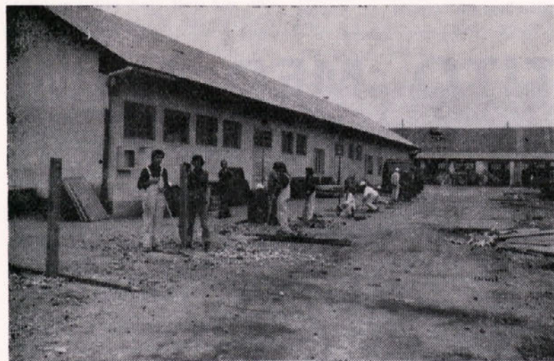
Pripravljena dela za novo upravno stavbo so pričeli naši učenci, bodoči zidarji...
