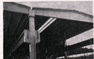
Centralna kotlarna v Ratanjski vasi, zgrajena po našem montažnem sistemu
