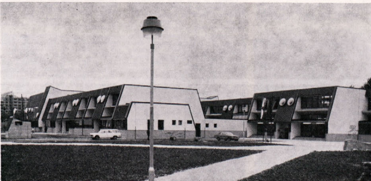
Se posebej slovesno so se ta mesec odprla šolska vrata v Žalcu, saj so učenci vstopili v novi objekt, ki so ga postavili delavci iz TOZD GO Zalec
