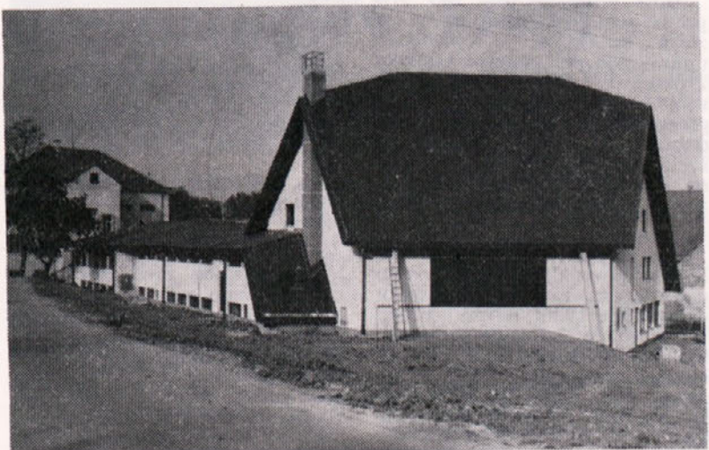
Na objektu kulturni dom Šmarje se dela zaključujejo
