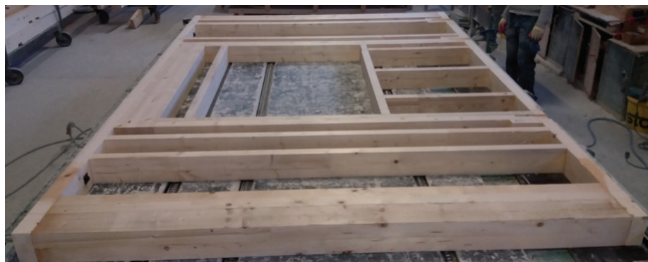
Slika 15 • Dokončana lesena nosilna konstrukcija stenskega elementa.
