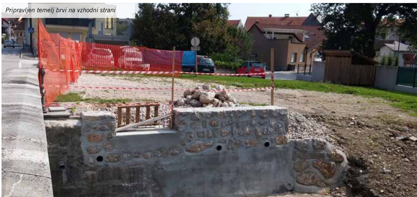
Pripravljen temelj brvi na zahodni strani
