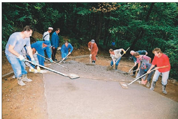
Betoniranje ceste do Piškovih v Janskem Vrhu
