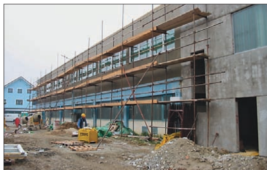
Izgradnja poslovnih prostorov za Goja, d.o.o.
