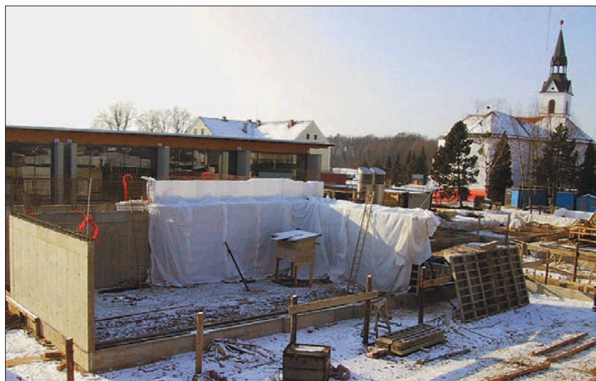
Gradbišče nove osnovne šole v Gorišnici
