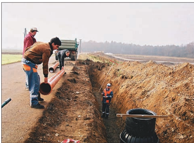
V obrtni coni Novi Jork, ki nastaja v revitalizirani gramoznici, so že položili vodovod in kanalizacijo
