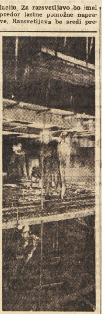
Razporejeni na ograjdu v treh nadstropjih rinejo minirji kot krti skozi granit. Predor njihovih vrtalnih strojev je taksen, da se med seboj spo- razumevajo s svetilkami. Poleg tega je v strovu zelo vlažno in za sedaj hladno. Pozneje pa bo neznosna vročina, tudi do 40 stopinj Celzija
