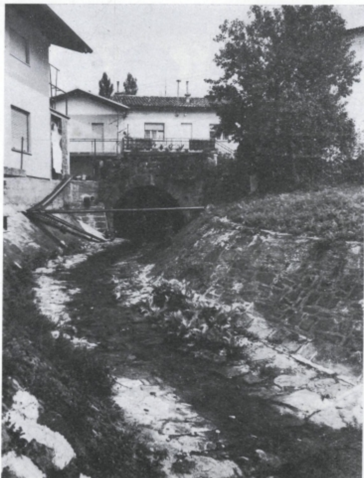
Sl. 2. Kuteževo. Pogled navzgor proti vasi in na dobro dimenzionirano ter lepo obzidano strugo potočka, ki prav zaradi tega ne poplavlja več.
