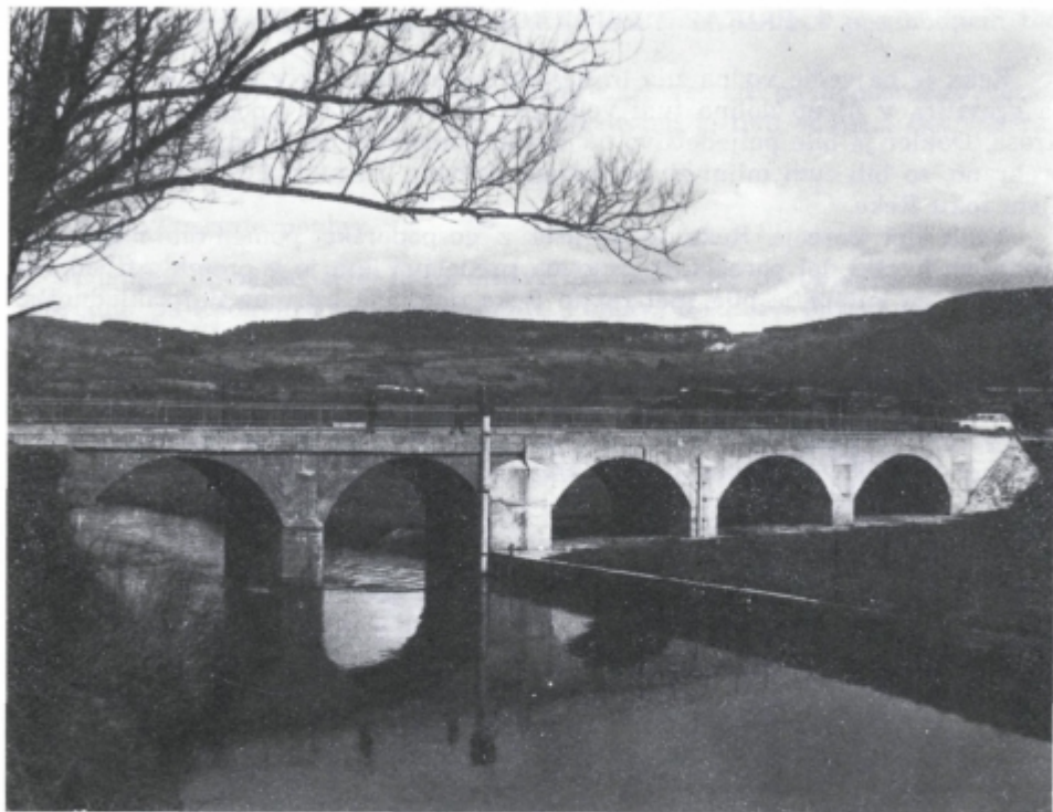
Sl. 3. Most čez Reko pri Rečici. Trije dodatni prepusti in nasip na desni strani, obenem z akumulacijo na Molji, so poplave v bistriški kotlini močno omilili.
