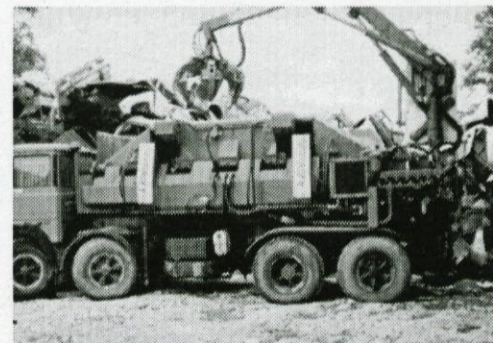
se je delo začelo in ... zaključilo
