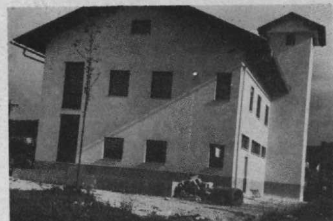
Novi gasilski dom v Dolu.
