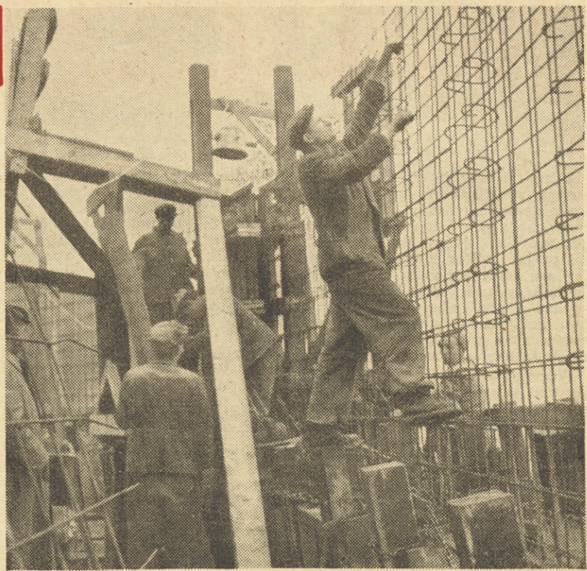
Pri dviganju prvega jarma sodelujeta dve brigadi. Na tej sliki je tudi Zlendrova brigada, na drugi pa Ciglerjeva, ki tudi dviga svoj prvi jarem opažev na drugem hladilnem stolpu šoštanjске termoelektrarne.
