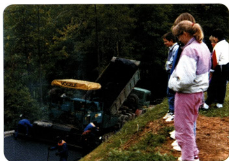
Učenci radovedno opazujejo svež asfalt
