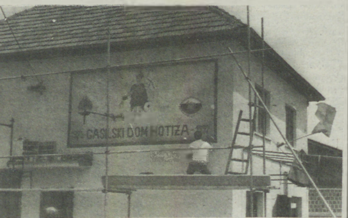
Gasilec s Hotize so s pomočjo krajevne skupnosti obnovili pročelje gasilskega doma, poleg tega so uredili še žlebove in prebarvali okna in vrata. Nazadnje pa so pripeljali še slikarja, ki je naslikal zaščitnika gasilcev — sv. Florijana. Za vsa dela so porabili 128.000 tolarjev. Foto: J. Ž.
