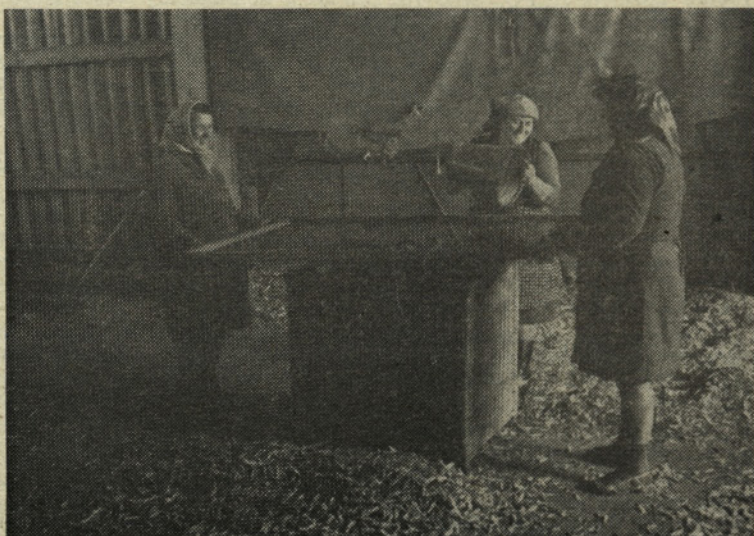
Po luščenju na stroju se grobo ločijo luščine od zrnja kar z mrežo napeto na okvir
