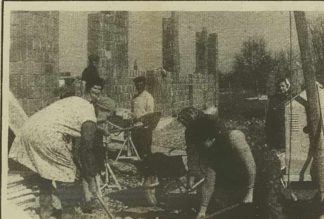
Ker je gasilski dom že pretesen, so se krajani v Vanča vasi odločili za gradnjo dvorane, sanitarij in mlekarne. Zemeljska dela so opravili čez zimo in navozili že tudi opeko. Dela opravlja Temelj iz Cankove, veliko pa pomagajo tudi vaščani s prostovoljnim delom.
