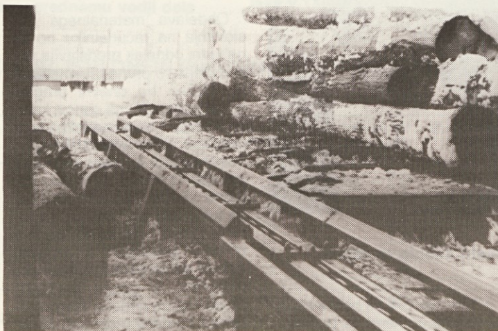
Prečni in vzdolžni transporter v žago na Škofljici. (Izdelek Hoja Ljubljana)
