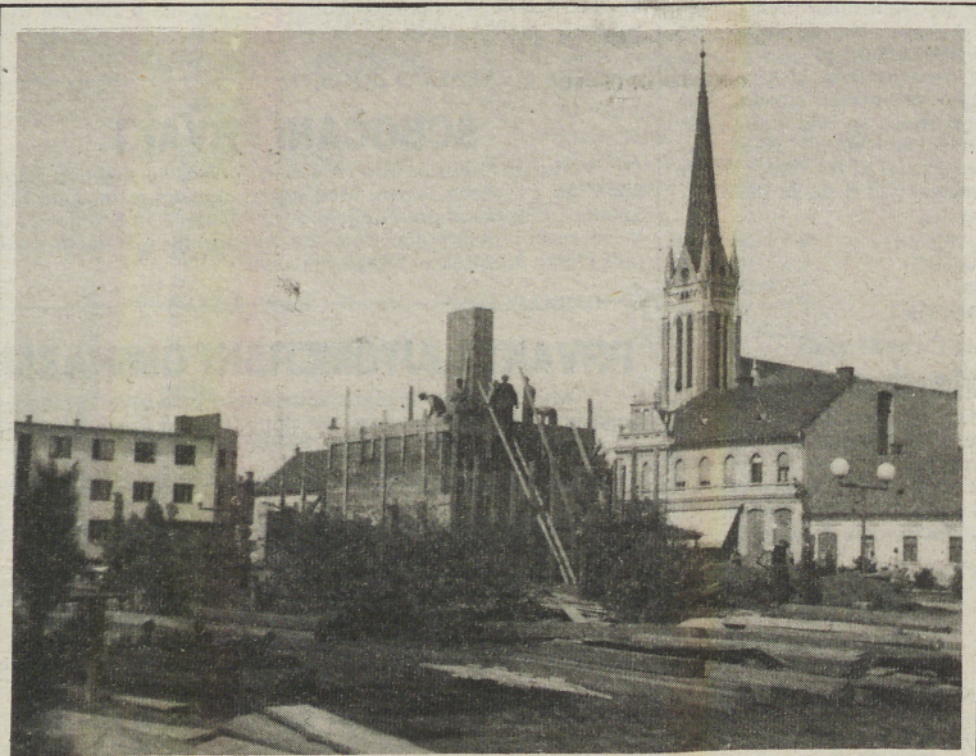
Gradnja soboškega spomenika zmage — ob otvoritvi je skrbel za zavarovanje prav BH/PM.
