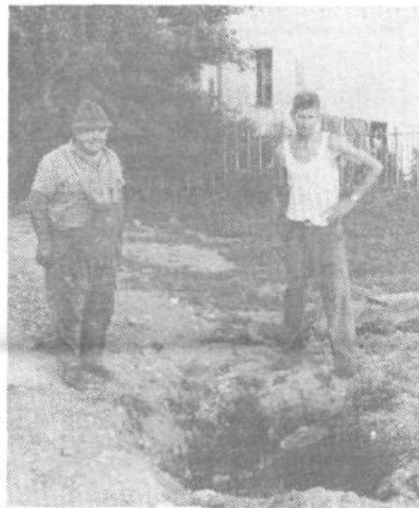
Marjan Debevec in Ivan Burger pred hidrantom novega vodovoda
