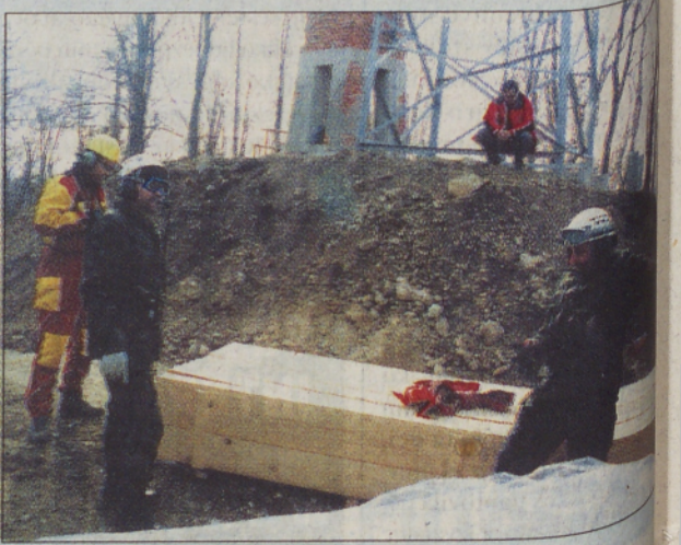
... in 'zemeljska enota' že na vrhu
