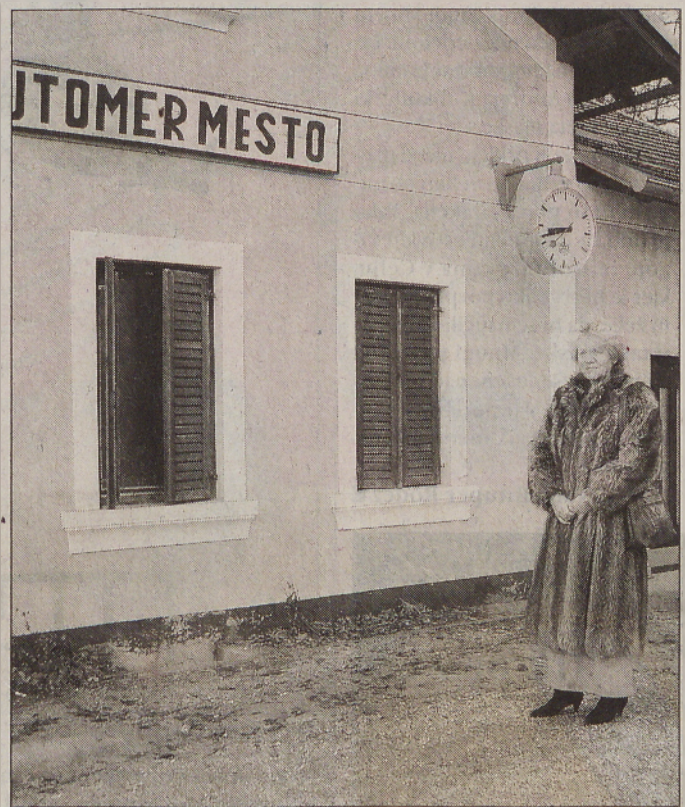
Cvetka ne more in ne more razumeti, zakaj postajna hiša propada, predvsem z dvoriščne strani, zakaj je zanemarjena okolica, zakaj ... (Foto: J. G.)
